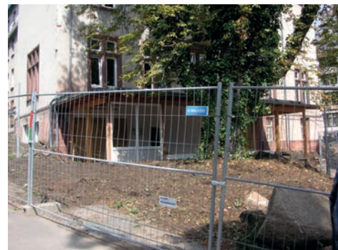
Abriss altes Gebäude
